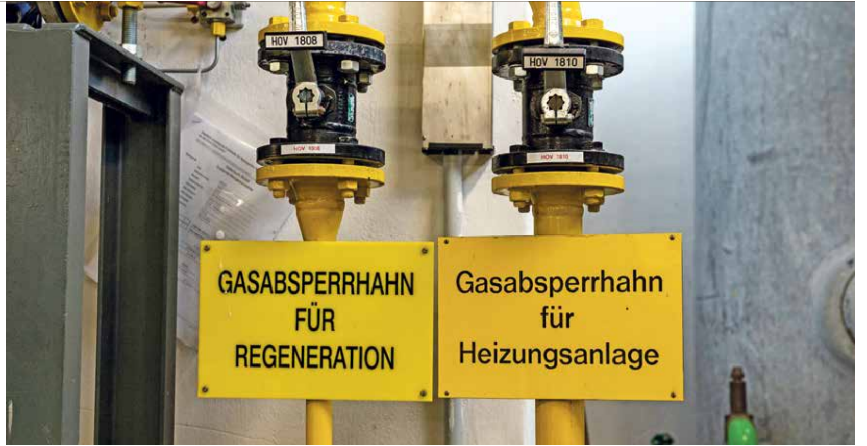
Absperrhähne eines Gasspeichers in Kiel-Rönne: Ist die Versorgungssicherheit ohne Lieferungen aus Rußland wirklich gewährleistet?
