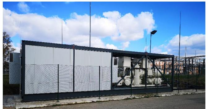
ABBILDUNG 4: 110 kV-MESSCONTAINER IN DER SCHALTANLAGE JENFELD.
